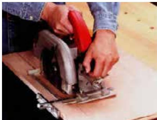
شکل ۱۳-۱۶ برش با استفاده از گونیای ماشین.
