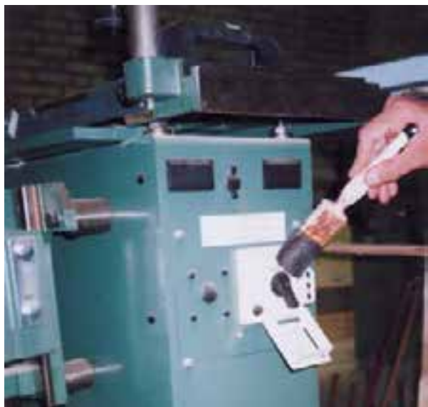
شکل ۱۵-۱۰- گردگیری و تمیز کردن کلید برق.
