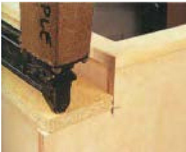
شکل ۸-۲۰- اتصال تخته خرده چوب به کابینت.
