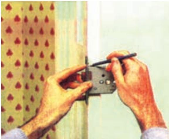
شکل ۱۰-۴۴- فلکشی محل قفل روی نر کار.
