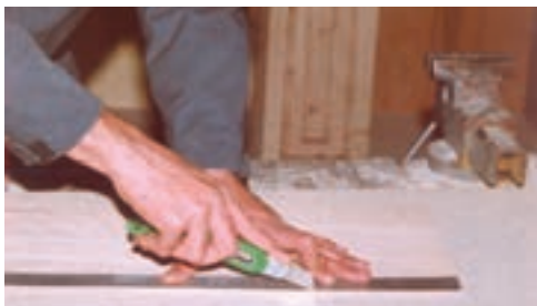
شکل ۵-۲۹- برش (روکش با کاتر)
