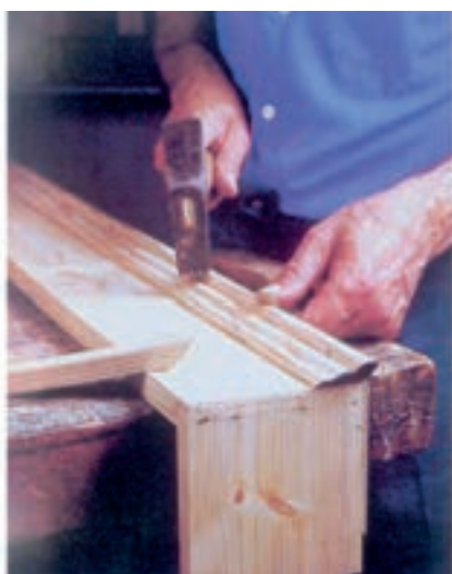
شکل ۱۰-۱۳- نصب زهوار با میغ.
