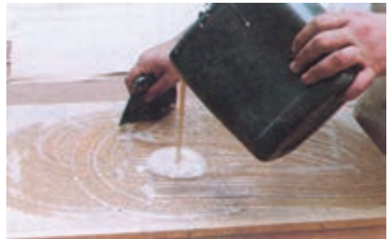
شکل ۶-۶. پخش کردن چسب به وسیله‌ی شانه‌ی چسب‌زنی.
