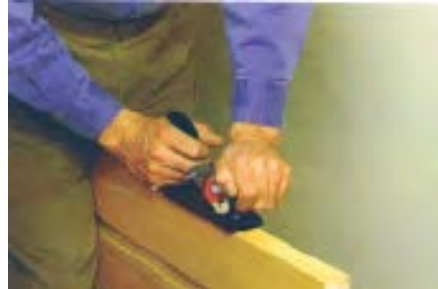
شکل ۲۰-۲- پوشالبرداری، یکنواخت و در جهت راه چوب باشد.
