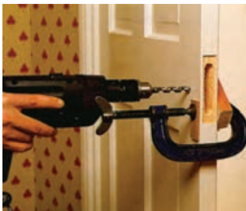
شکل ۱۰-۴۸- سوراخ‌کاری ممل پلاک و دستگیره‌ی قفل.
