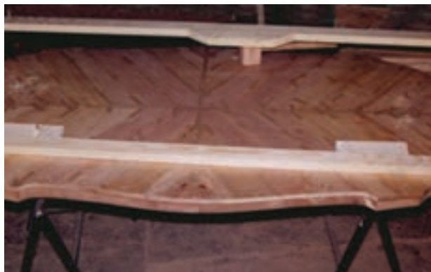
شکل ۱۱-۳۲- کلاف آماده شده برای شبکه‌ریزی.
