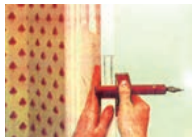
شکل ۱۰-۴۳- فلکشی محل قفل با فلکشی تیره‌دار.
