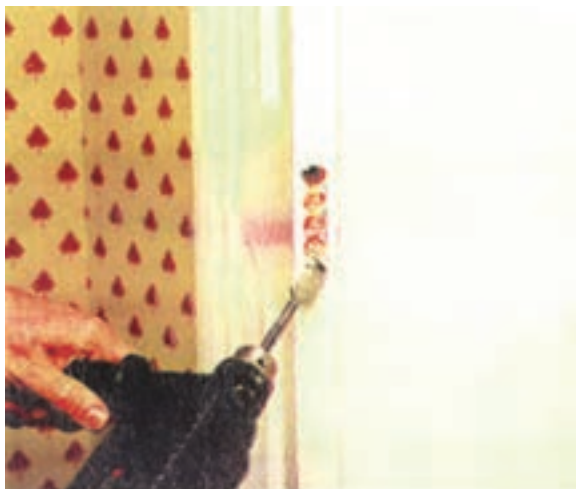
شکل ۱۰-۴۵- تفلیهی محل قفل با دریل.
