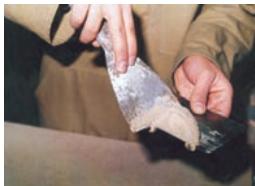
شکل ۸-۴- کاربرد لیسه و کاردک هنگام بتونه کاری.
