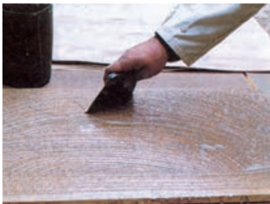
شکل ۱۶-۶- چسب را به وسیله‌ی شانه، روی صفحه‌ی مصنوعی پخش کنید.
