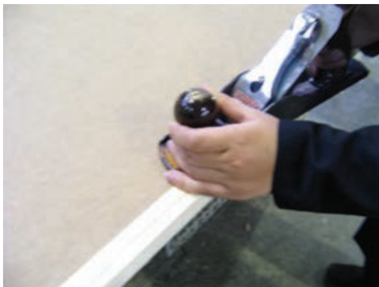
شکل ۱۹ - هم سطح کردن لبه‌ی اضافی زهوار با سطح نئوپان
