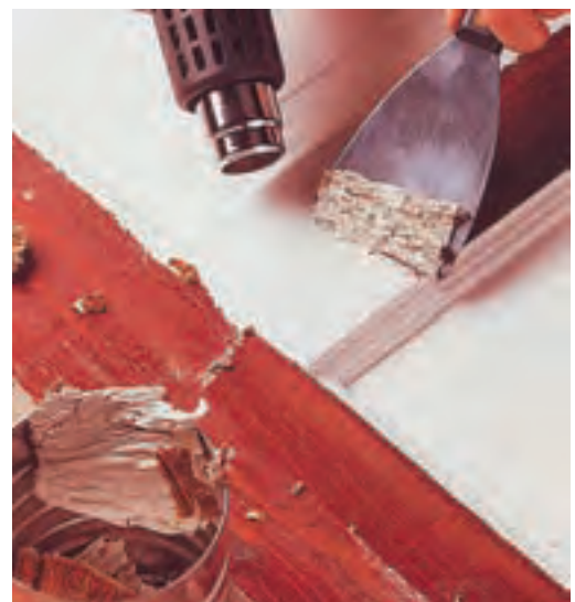
شکل ۱۲-۱۱- برداشتن رنگ به روش حرارتی.
