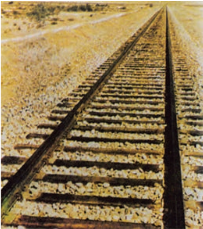
شکل ۱-۶- تراورس راه آهن اشباع‌شده با کروتوزوت
