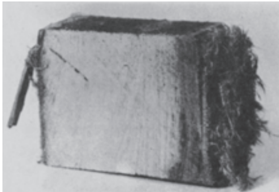
شکل ۲۶-۵-ج - چوبی که در اثر یک قلیایی تخریب شده است.
