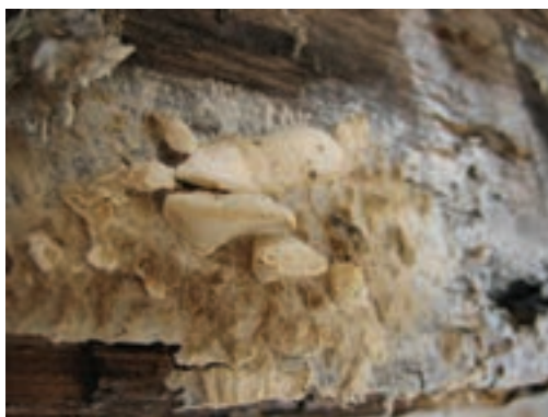
شکل ۵-۵. قارچ عامل پوسیدگی قهوه‌ای که غالباً در محل‌های مرطوب (زیر زمینی) رشد می‌کند.
